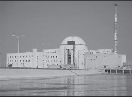
نمای کلی از نیروگاه هسته‌ای بوشهر
